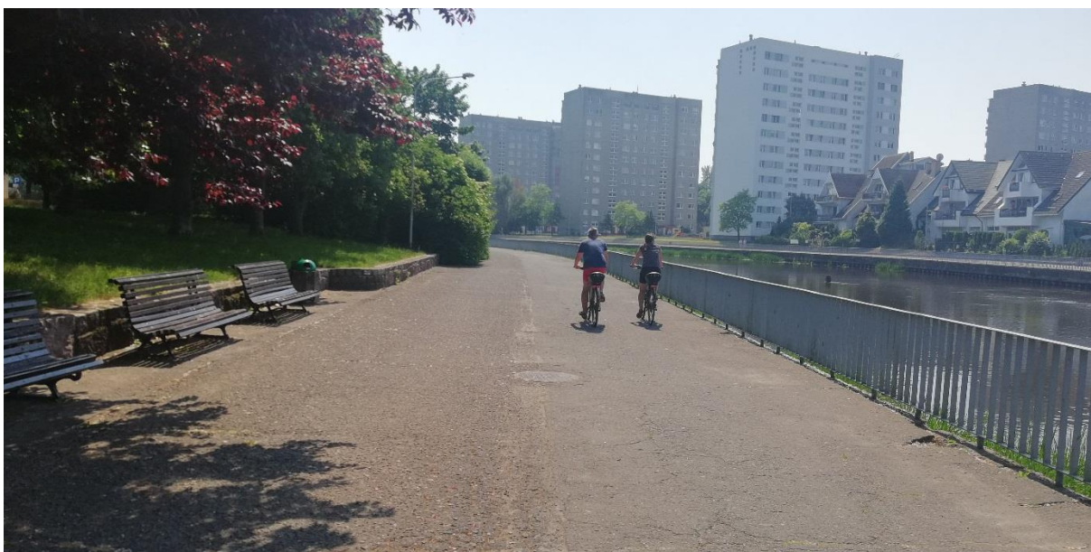
Rysunek 5. Bulwar nad Parsętą i bulwar Marynarzy Okrętów Pogranicza wymagają kompleksowej przebudowy i dostosowania do potrzeb użytkowników.
